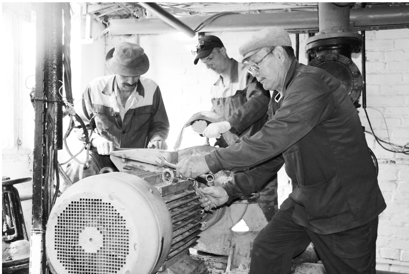
Идет ремонт в котельной № 8 (район РТП).
